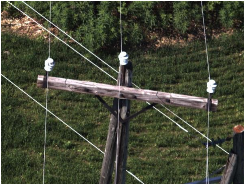
Kuva 24. Keskijännitepylväs puuorrella vuodelta 1951
