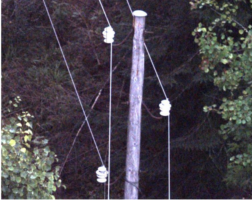
Kuva 23. Keskijännitepylväs koukkuorsilla vuodelta 1971
