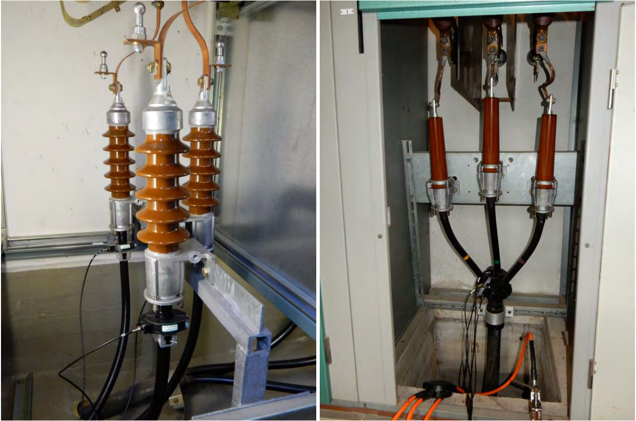
Kuva 2.8. Posliini- ja valuhartsieristeiset 20 kV kaapelipäätteet.
