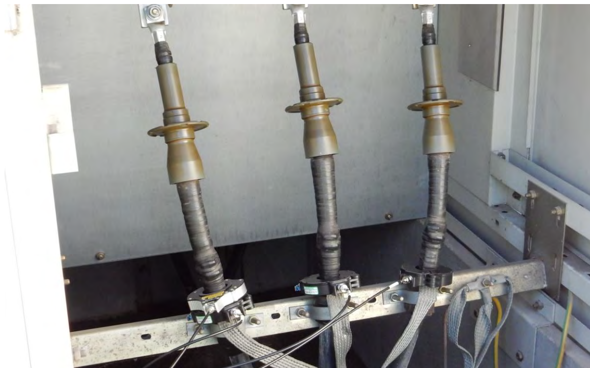
Kuva 3.8. HFCT-anturit asennettuna mitattavan kaapelin vaiheiden ympärille asennustavalla, jolla saavutetaan paras mittausherkkyyks.
