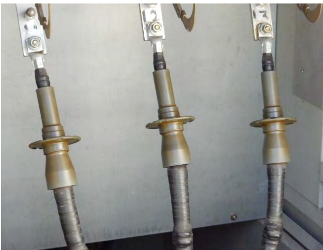
Kuva 2.10. Esivalmistetut 20 kV kaapelipäätteet (ABB Kabeldon).
