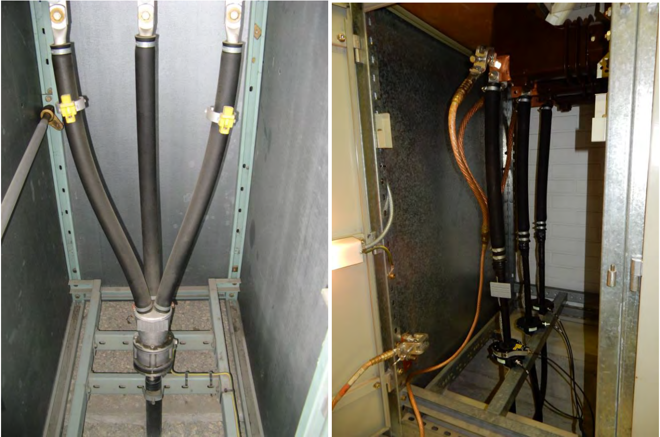
Kuva 2.9. 10 kV letkupäätteitä. Oikeanpuoleinen asennustapa mahdollistaa on-line-osittaispurkausmittaukset HFCT-antureilla, kun vaihejohtimet ovat kosketussuojatulta osuudeltaan riittävän etäällä toisistaan.
