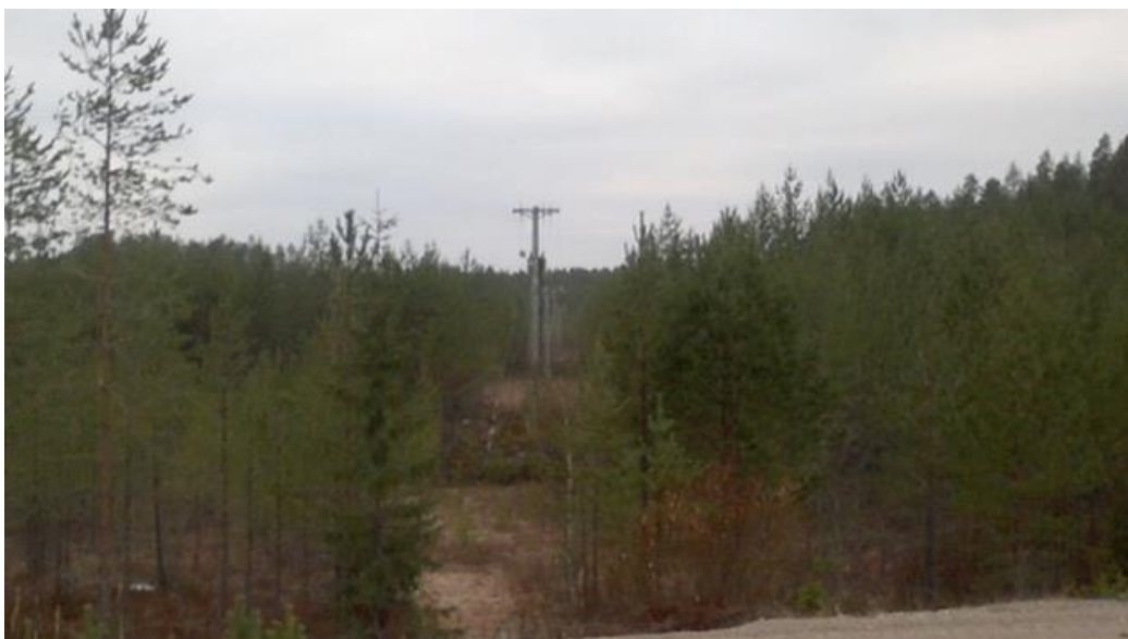
Kuva 8. Testilennon kohteena olleen 20 kV:n linjan päätepylväs Rallikeskuksessa
