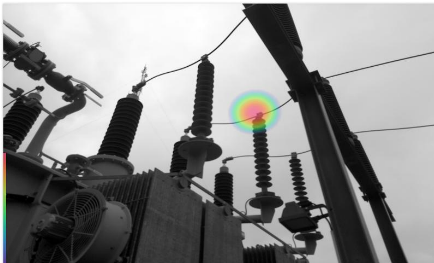
Kuva 4.13. Koronapurkausta Viialan sähköasemalla ylijännitesuojan päässä (27.5.2019, 10 °C, 73 %).
