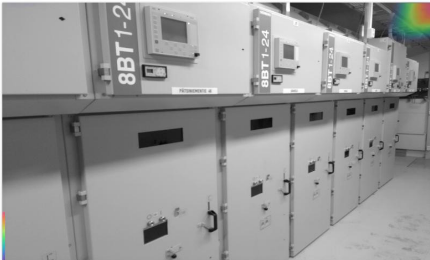
Kuva 4.14. Toijalan sähköasema 20 kV:n kojeisto.
