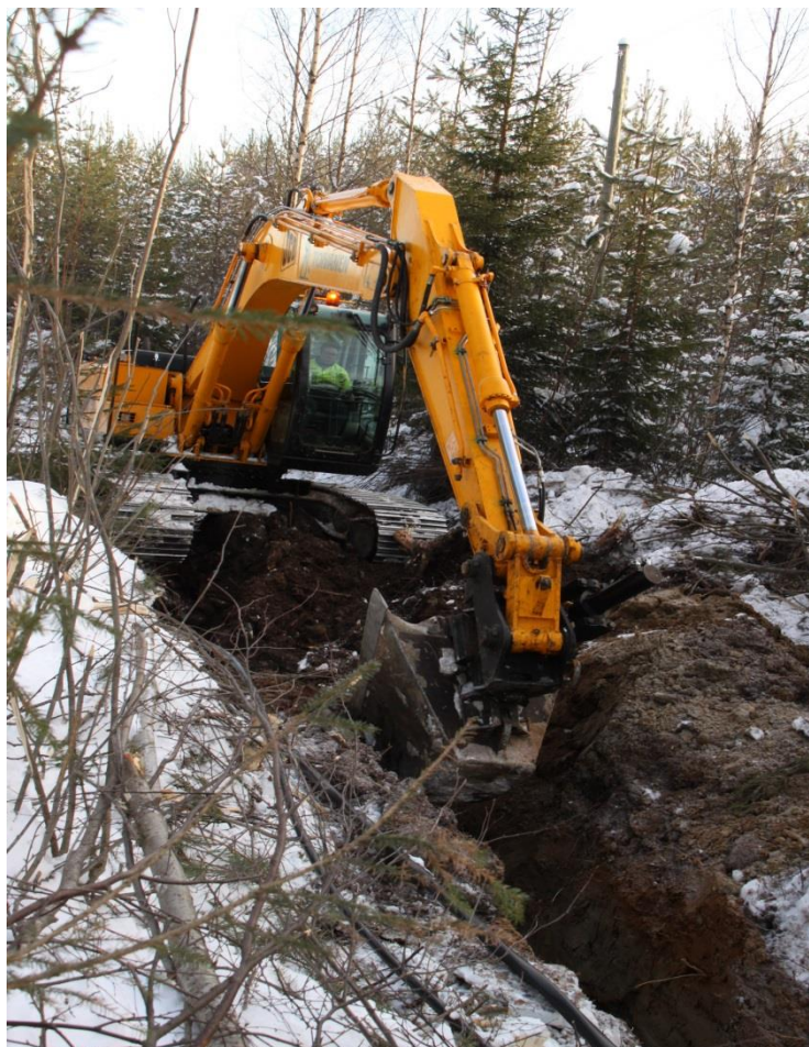
Kuva 6.1. Kj-kaapelin kaivu metsässä (Intra, 2015).
