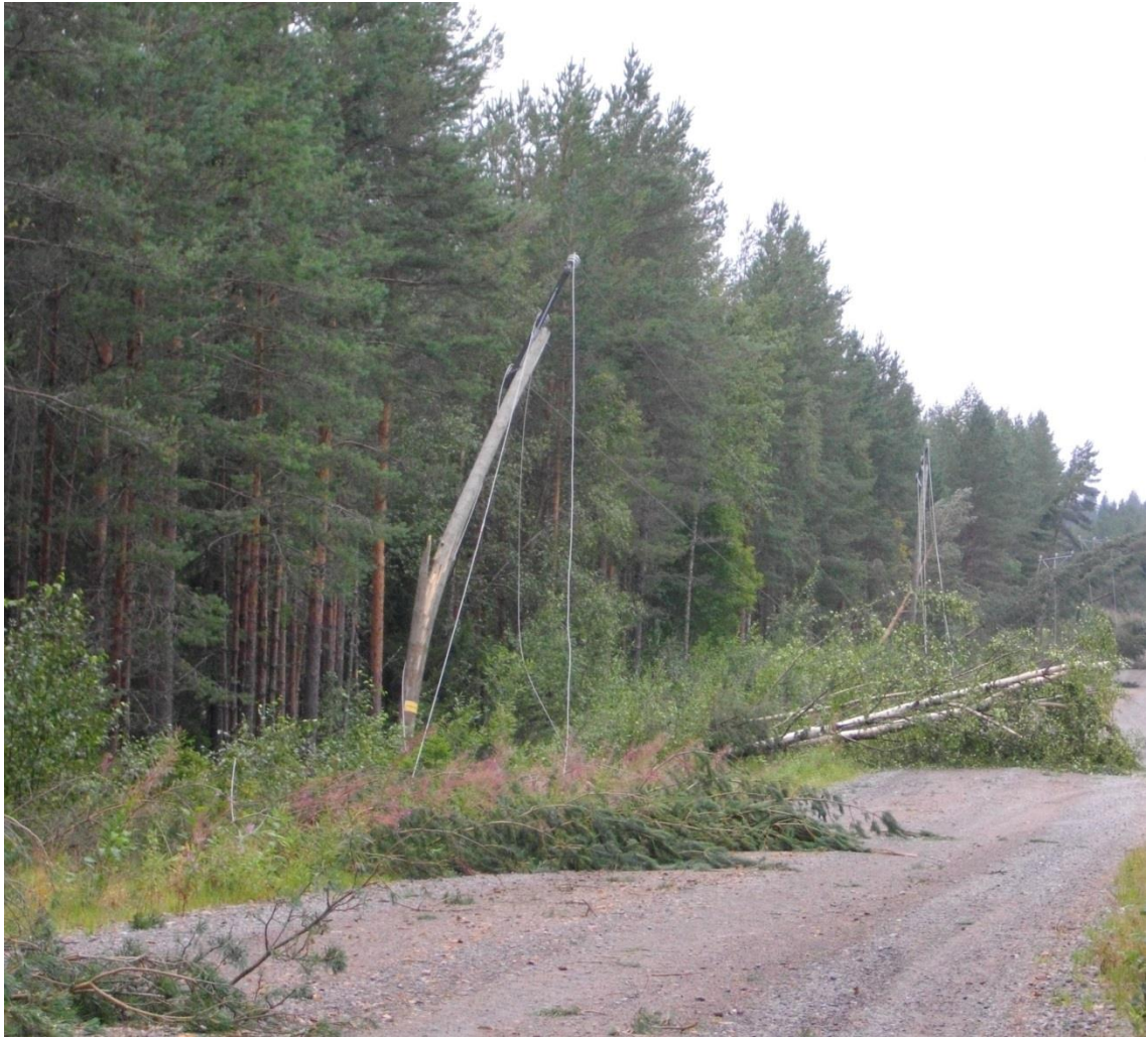
Kuva 6.3. Myrskyn seurauksena tuhoutunut 20 kV avojohtolinja (Intra, 2015).
