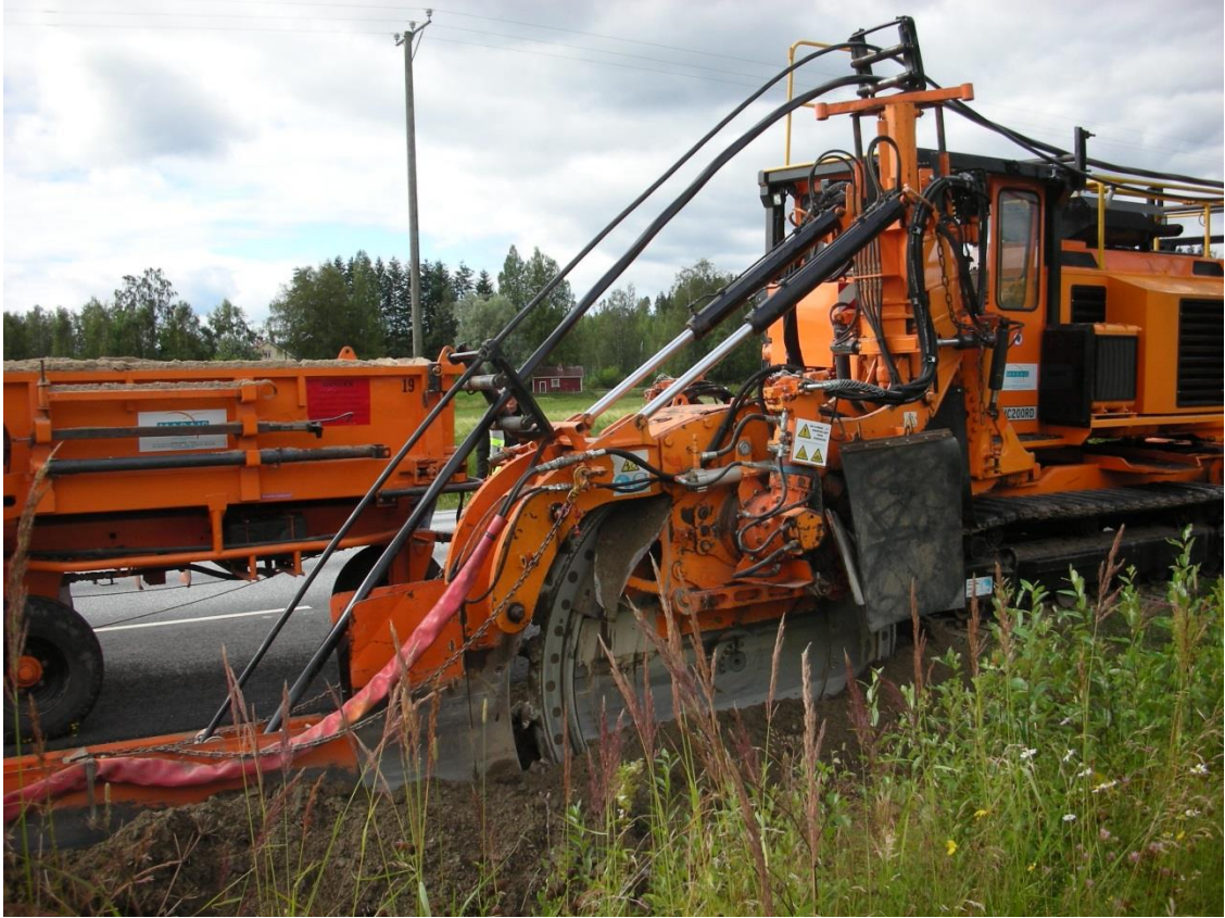
Kuva 6.2. Kj-kaapelin asennus kaapelinauraukoneella tien varteen (Intra, 2015).
